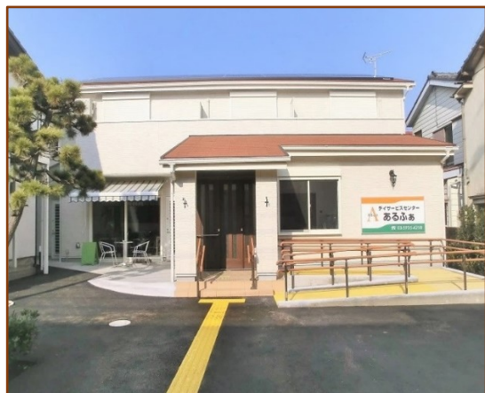
屋外での広いスロープを利用して 歩行練習も実施しています。
